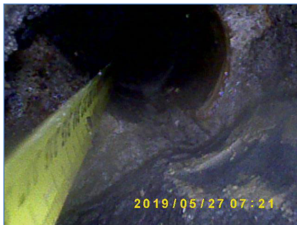
Immagine a 320 cm dalla fine del foro. Elementi lapidei e malta.
