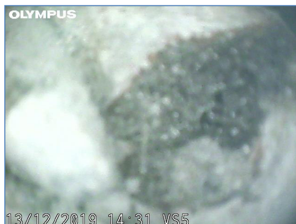
Immagine a 22 cm dall'inizio del foro. Massetto.
