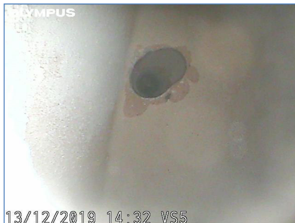
Immagine a 5 cm dall'inizio del foro. Elemento in laterizio.
