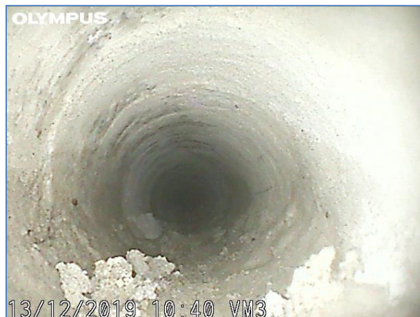
Immagine a 70 cm dall'inizio del foro. Elementi lapidei e malta.
