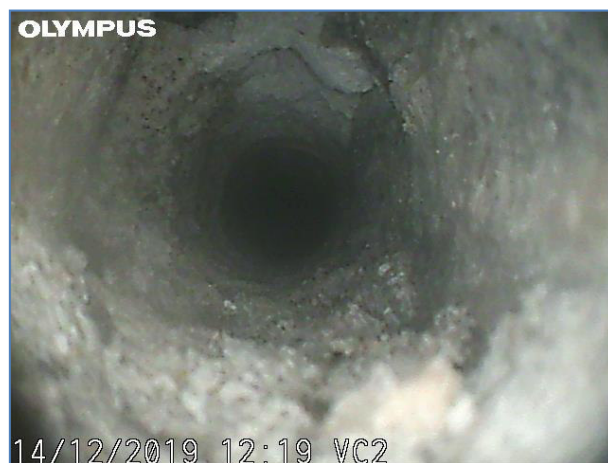
Immagine a 25 cm dall'inizio del foro. Muratura mista e cls compatto.
