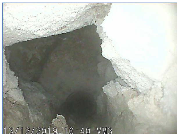
Immagine a 60 cm dall'inizio del foro. Elementi lapidei e malta.
