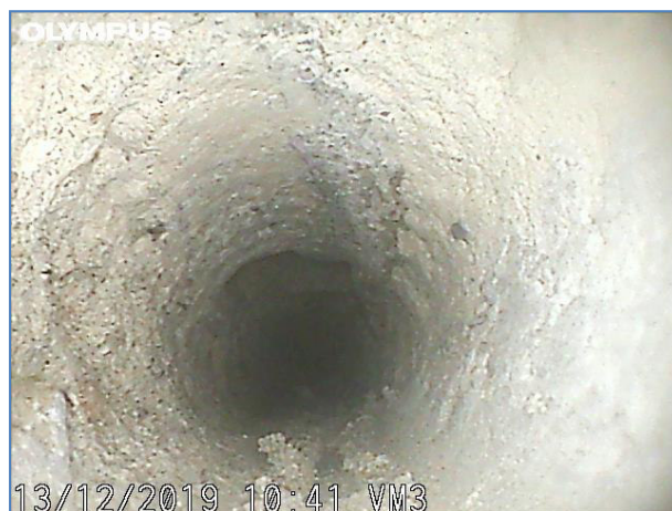
Immagine a 20 cm dall'inizio del foro. Elementi lapidei e malta.
