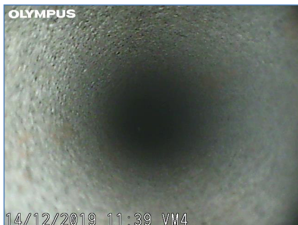
Immagine a 30 cm dall'inizio del foro. Muratura in mattoni.
