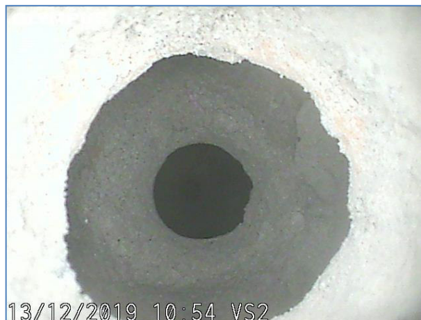
Immagine a 10 cm dall'inizio del foro. Massetto e elemento in laterizio.
