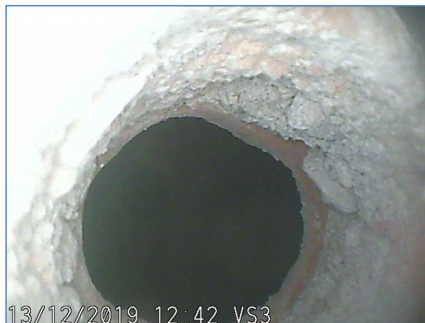
Immagine a 0 cm dall'inizio del foro. Intonaco e elemento in laterizio.
