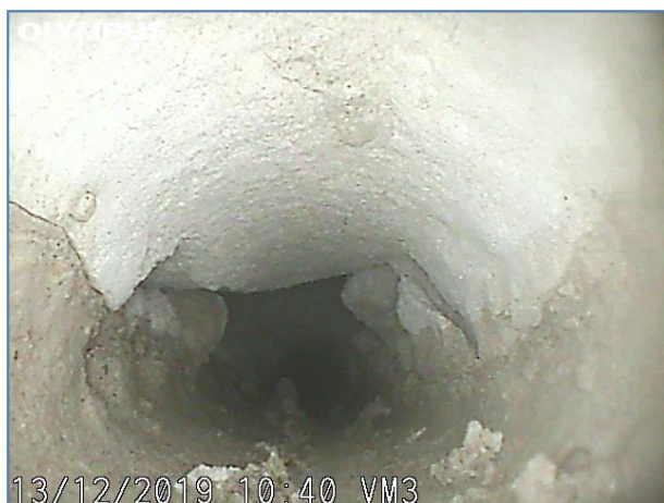
Immagine a 55 cm dall'inizio del foro. Elementi lapidei e malta.
