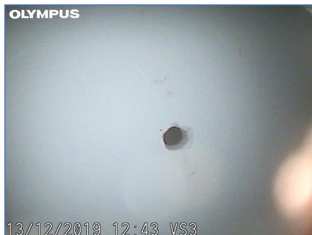
Immagine a 5 cm dall'inizio del foro. Elemento in laterizio e cls.
