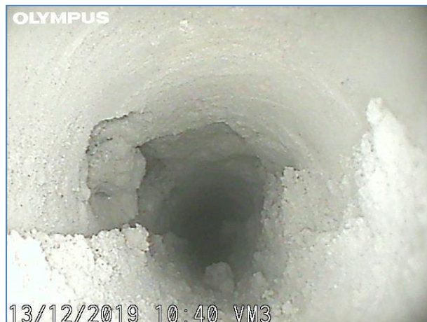
Immagine a 100 cm dall'inizio del foro. Elementi lapidei e malta.
