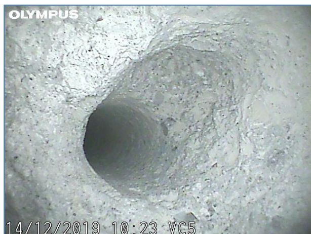
Immagine a 0 cm dall'inizio del foro. Intonaco.
