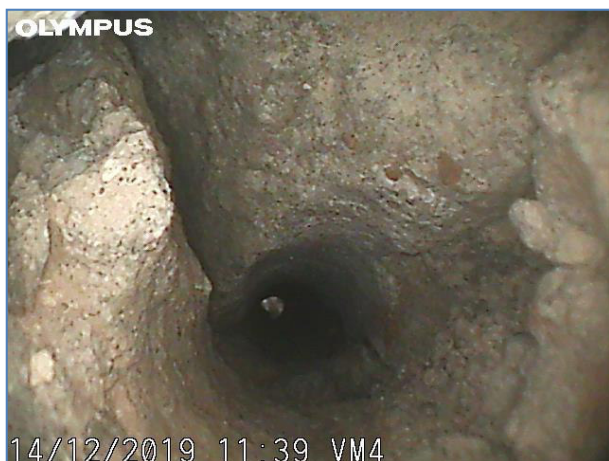
Immagine a 45 cm dall'inizio del foro. Muratura in mattoni.
