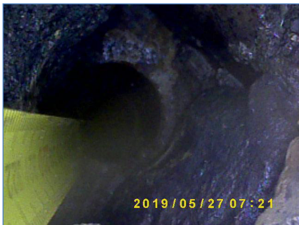
Immagine a 325 cm dalla fine del foro. Elementi lapidei e malta.
